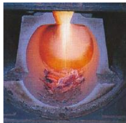
Bilde av kjelens etterforbrenningskammer og den blå/orange flammen som er kjennetegnet på totalforbrenning av røkgassene.
